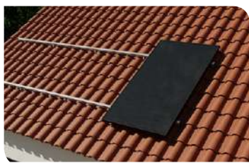
Étape 3 Pose panneau et micro-onduleur
