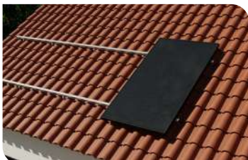
Étape 3 Pose panneau et micro-onduleur
